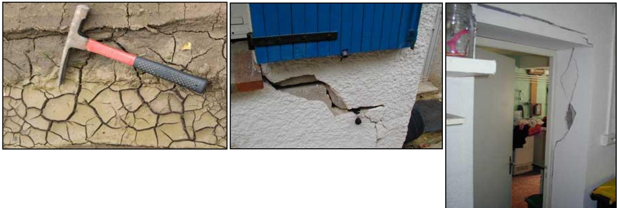
Illustrations du phénomène de retrait gonflement des argiles (source http://www.argiles.fr/ )
