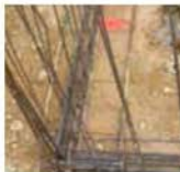
Noeud de chaînage - Continuité mécanique
