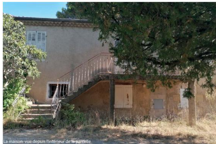
Vue sur la maison existante sur le site / Source : étude de faisabilité EPF PACA, septembre 2021
