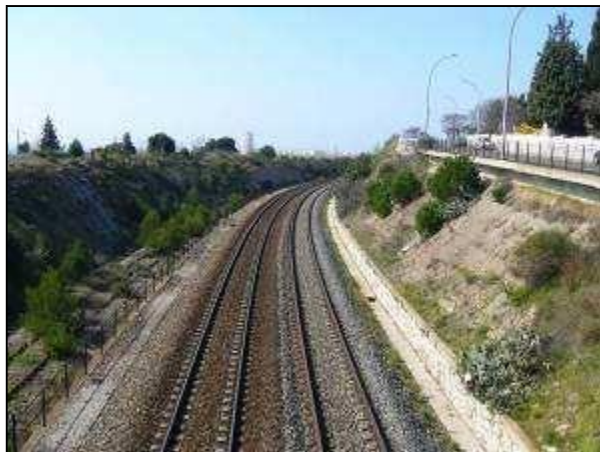
La voie ferrée
