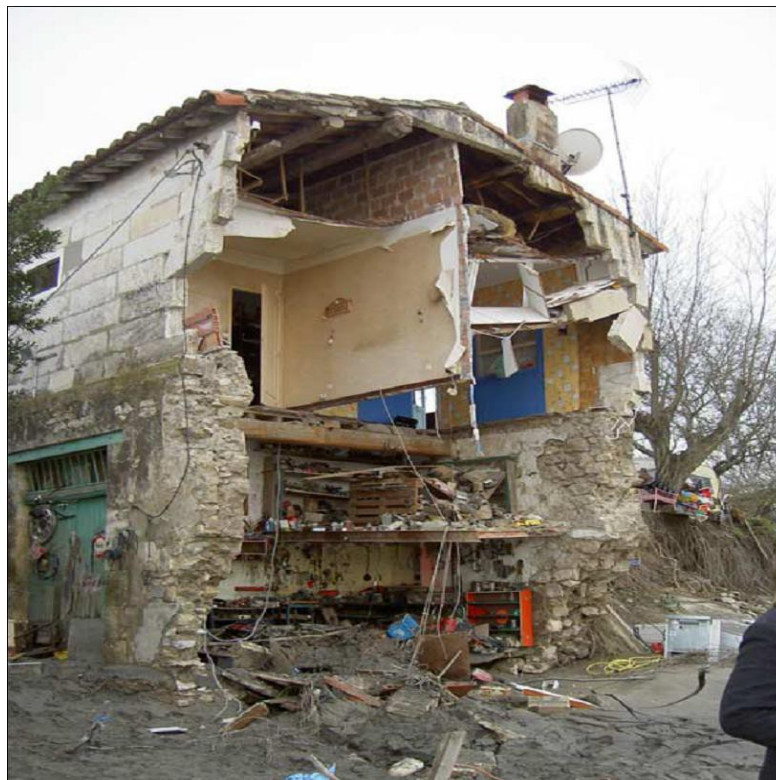
Maison du garde-digue, Fouques, décembre 2003
