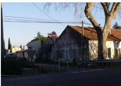
Vue depuis la RD7N de l'accès 2 roues
