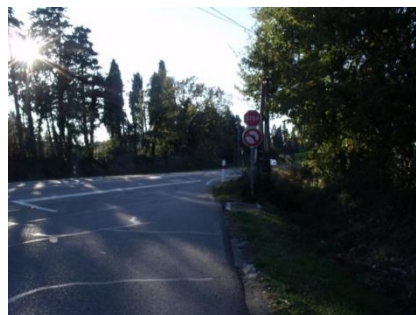
Intersection Ancienne route de Mallemort / RD7N
