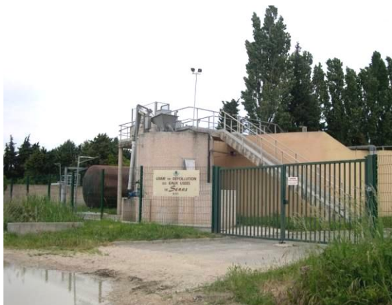
Station d'épuration de Sénas
