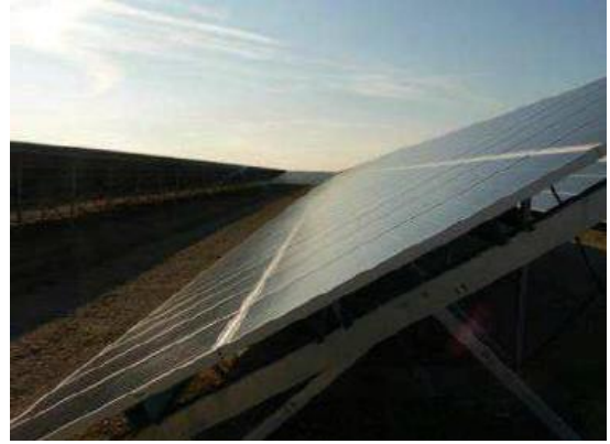
Modules photovoltaïques inclinés d'un angle de 30°, source étude d'impact
