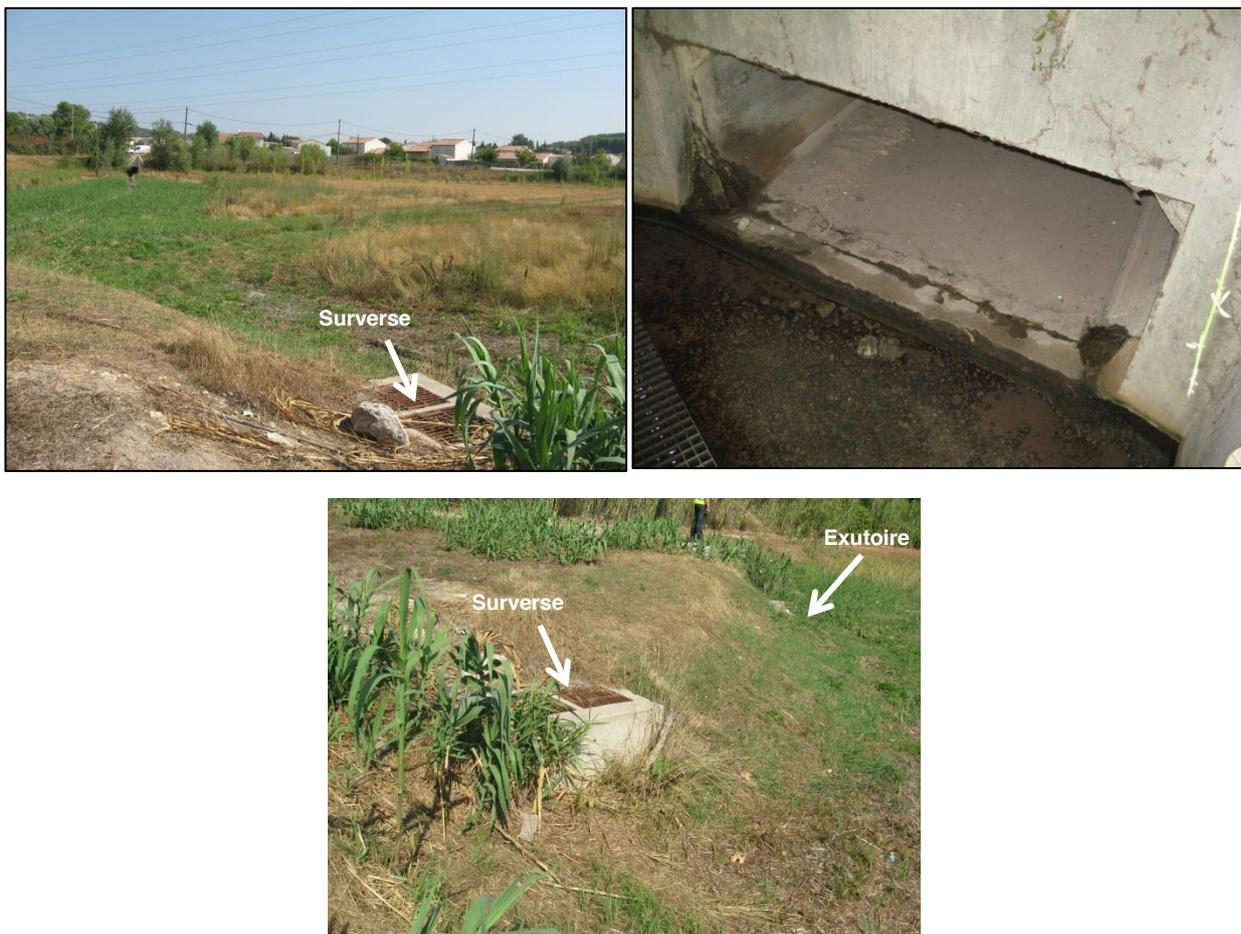
*Photographies de l'ouvrage de surverse du bassin de rétention du Plan*
