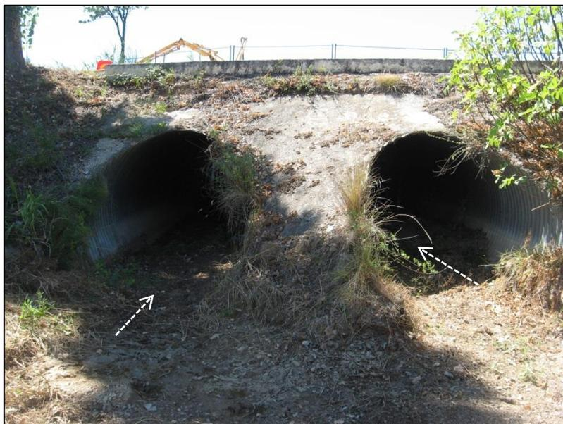
*Photographie (vue vers l'aval) du busage du Vallat Neuf par 2 canalisations en Ø 170 cm sous le chemin du Vallon des Brayes*
