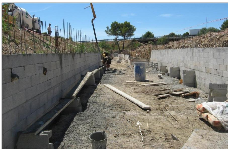
Photographie du cadre en cours de réalisation pour le busage du Vallat Neuf (vue vers l'aval)
