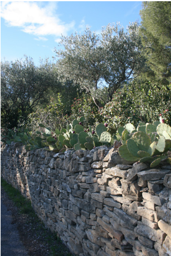
Une identité paysagère à préserver - Chemin des Poissonniers Les murets en pierre sèches et la végétation associée
