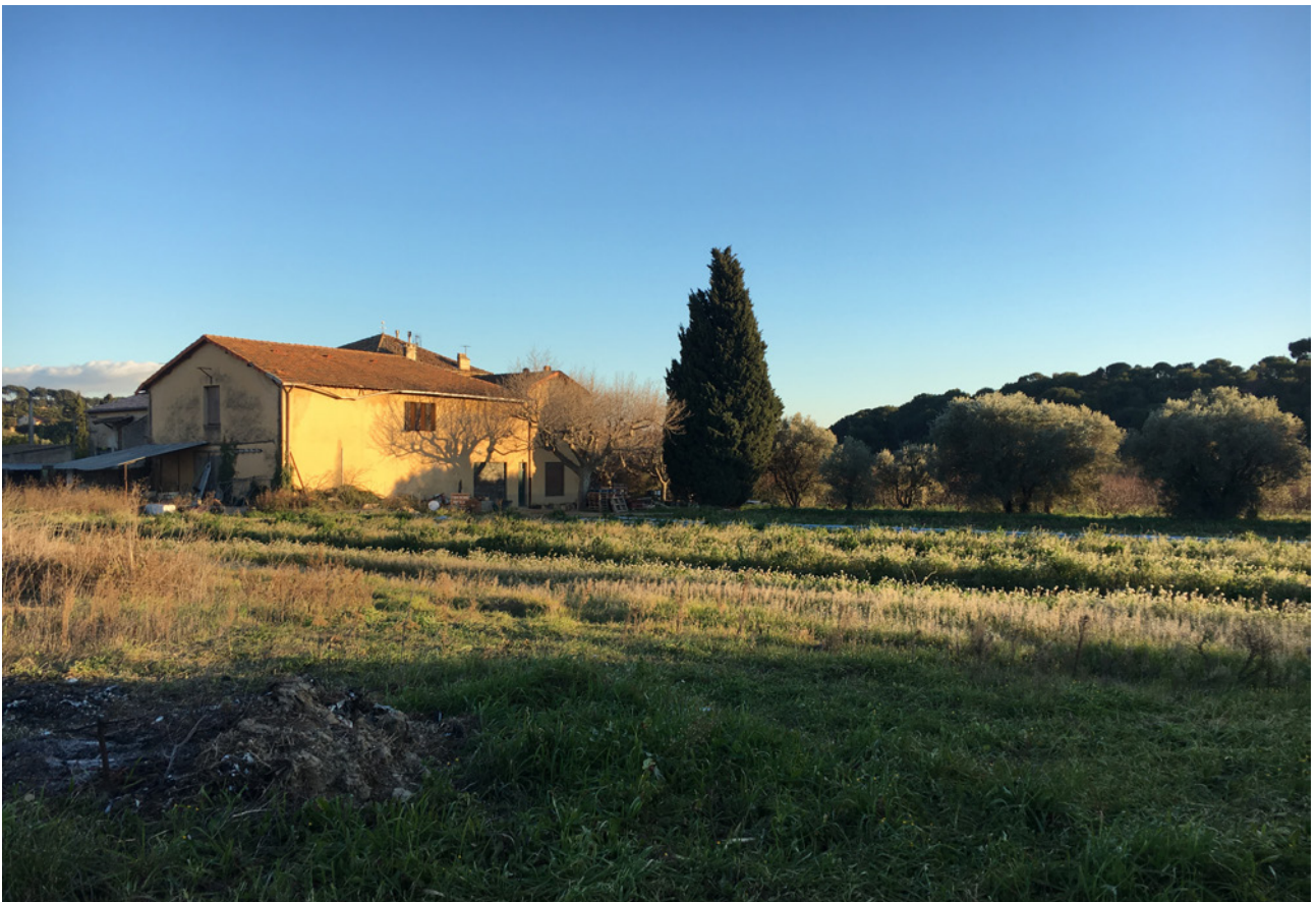
Un patrimoine à protéger La bastide Campanelle
