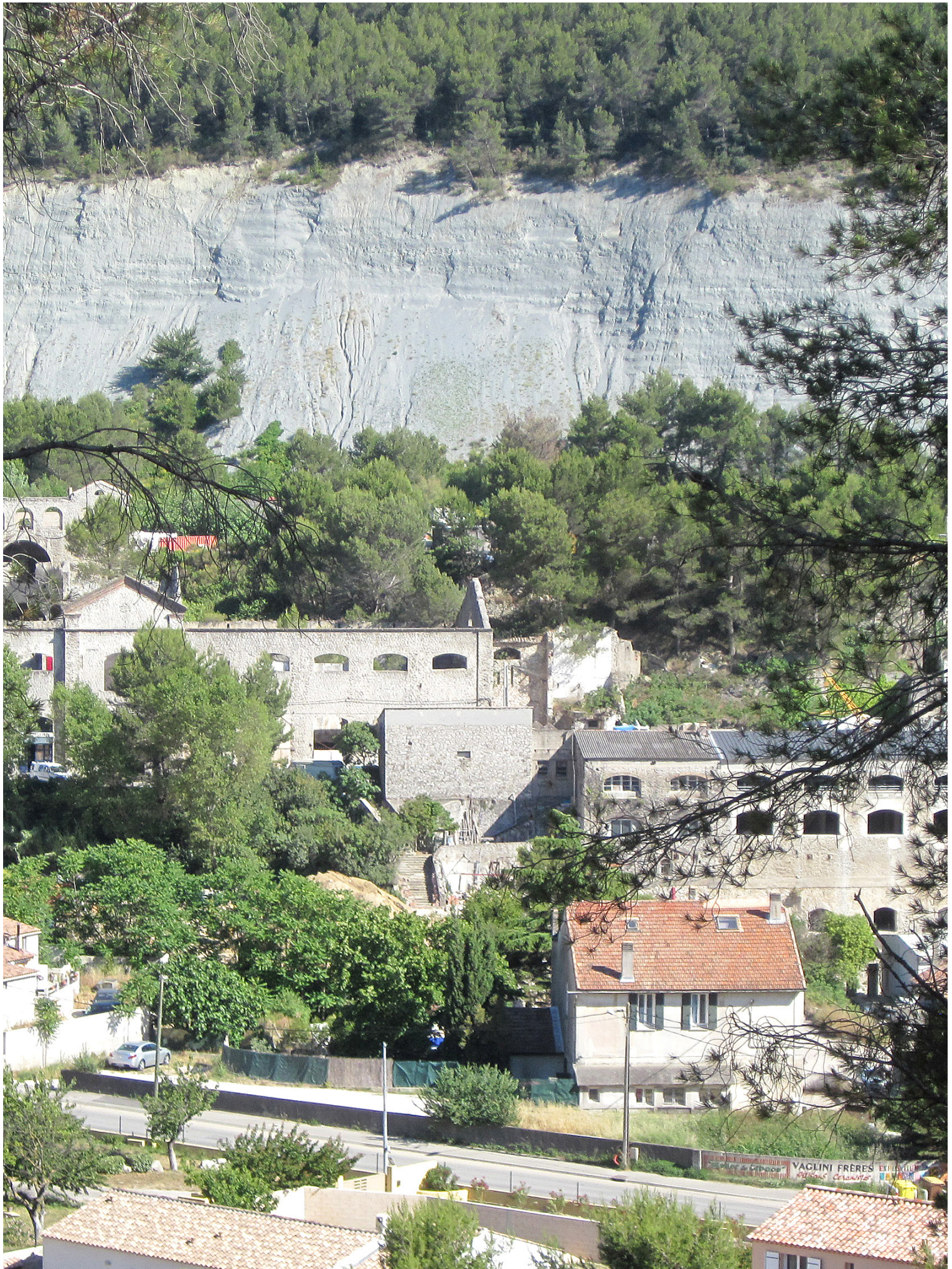
Vue actuelle du site de l'ancienne cimenterie
