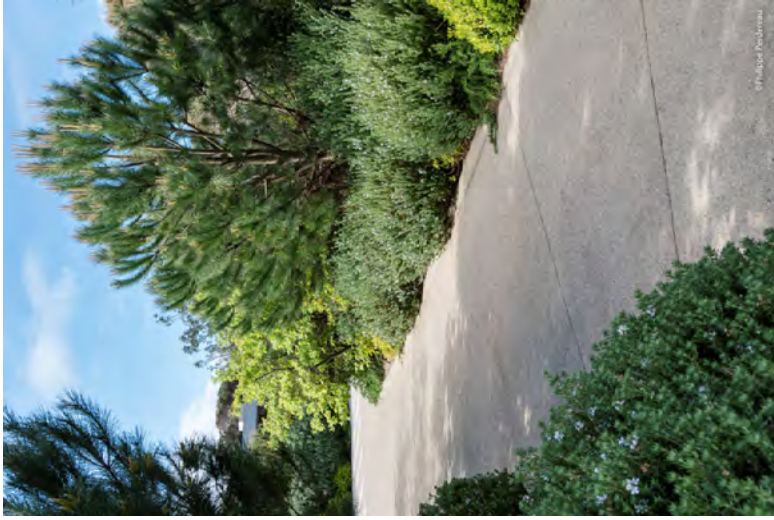
Béton teinté désactivé façon chemin de campagne avec ou sans incrustation de pierre
