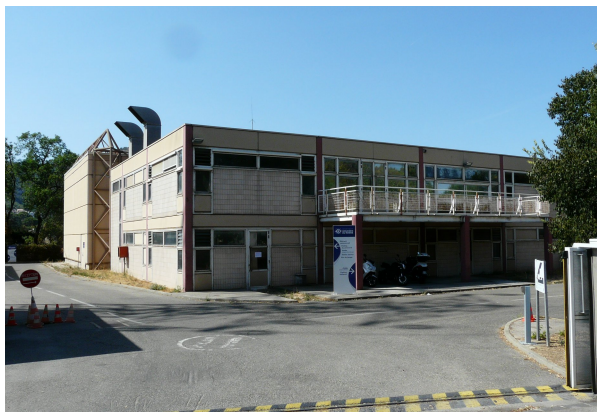
Bâtiment des services de l'Équipement (© Gomez)
