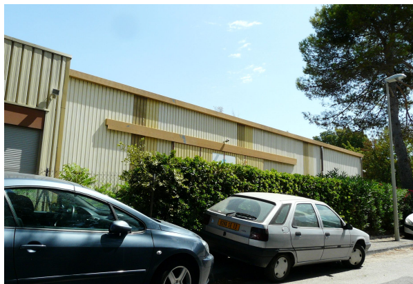
Zone artisanale au nord du château de la Buzine (© Gomez)
