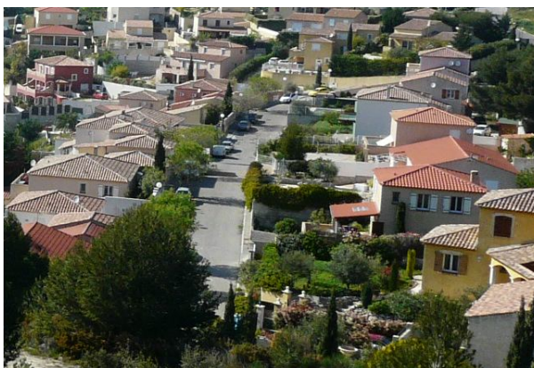
Premières constructions du lotissement des Baumillons Hauts (© Gomez)
