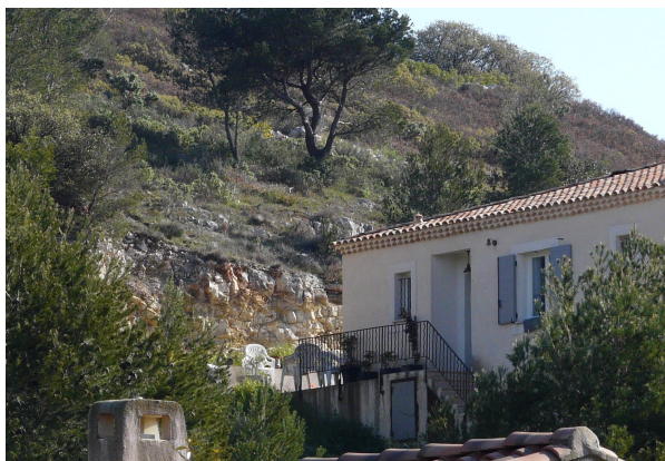
Excavation du rocher en piémont septentrional de l'oppidum (© Gomez)
