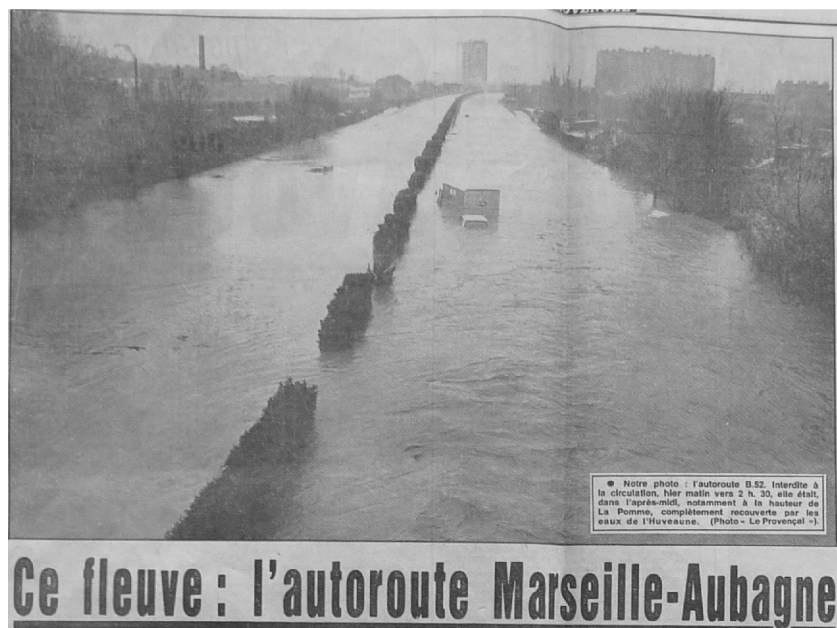
Figure 5 : L'autoroute Marseille-Aubagne lors de la crue de janvier 1978 (source : Le Provençal, janvier 1978)
