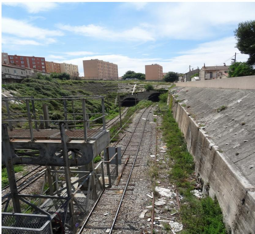
A ce niveau, une défluence anthropique peut conduire lors des débordements des Aygaldes à générer des inondations dans le secteur du GPMM au niveau des formes de radoub en raison des écoulements qui pourraient se produire à travers le tunnel ferroviaire du Canet.
