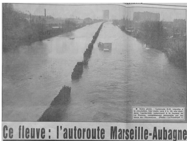
Figure 10 : L'autoroute Marseille-Aubagne lors de la crue de janvier 1978 (Source : Le Provençal, janvier 1978)
