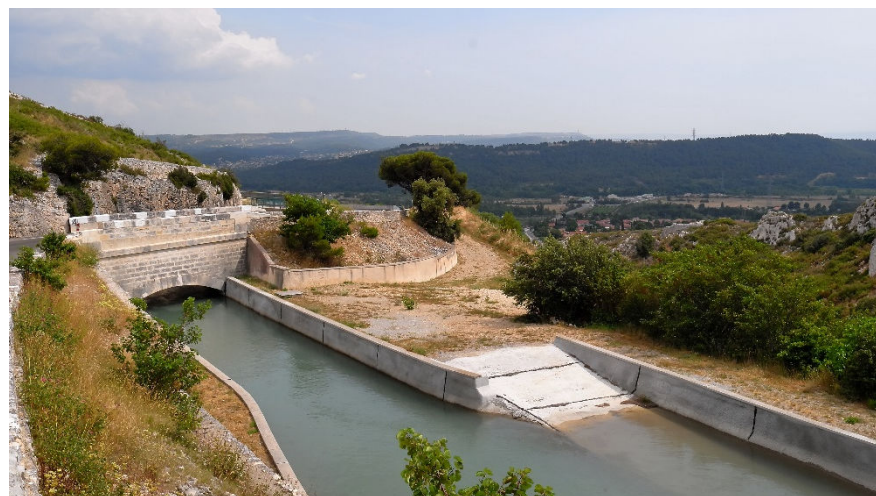
Canal de Marseille à Coudoux
