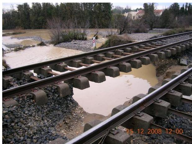
Rupture d'un remblai ferroviaire crue du Coulon le 15/12/2008
