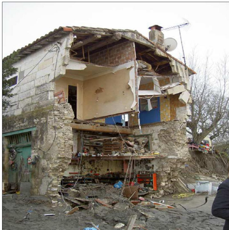
Maison du garde-digue, Fouques, décembre 2003
