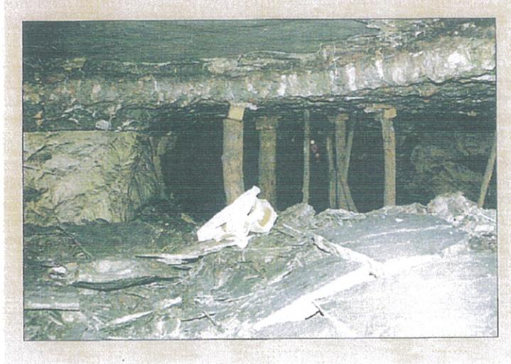
**Photo n°2 - Rupture de toit : Guide technique "cavités souterraines"**
