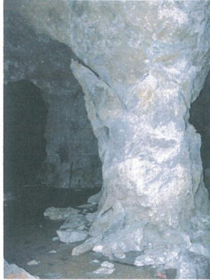
Photo n°1 - Rupture de pilier : Guide technique "cavités souterraines"
