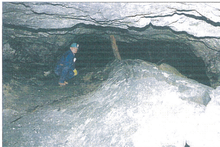
Photo n°3 - Soufflage du mur : Guide technique "cavités souterraines"
