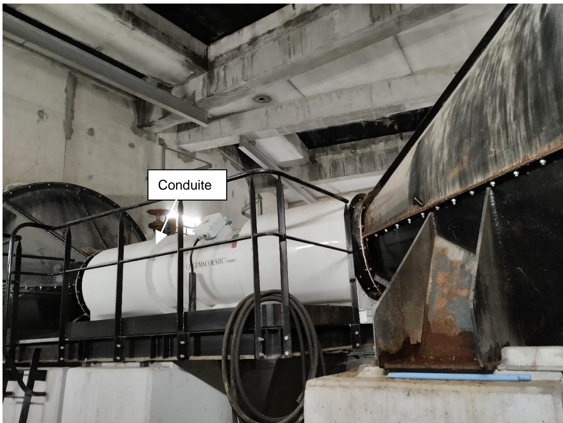
Photo 8 : Conduite de ventilation maintenue
