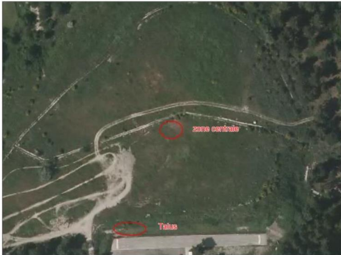
Zones d'échauffement repérées en 2014 sur le terril de Madame d'Andrée (source BRGM / DPSM, cf. [9])
