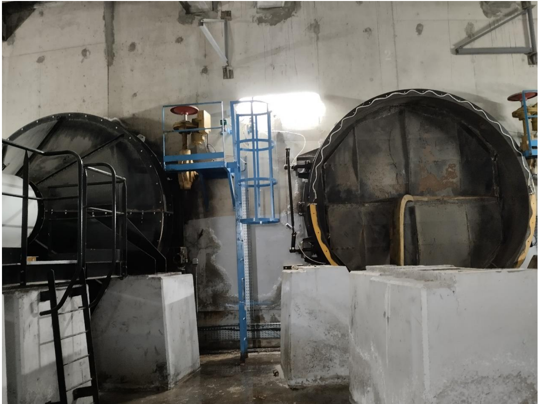
Photo 7 : Départ du rampant depuis le sous-sol des ventilateurs
