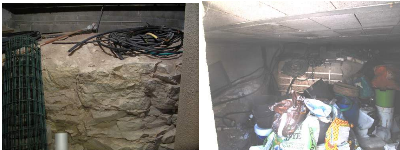
Figure 4 : Affleurements des calcaires du Fuvélien observés dans le sous-sol de l'habitation (AE n° 15) à gauche et le vide sanitaire de l'habitation (AE n° 82) à droite
