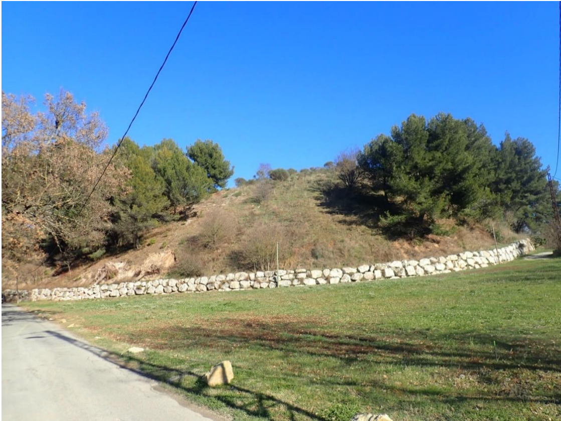
Terril Saint-Pierre (V137) – Vue du Sud-Ouest
