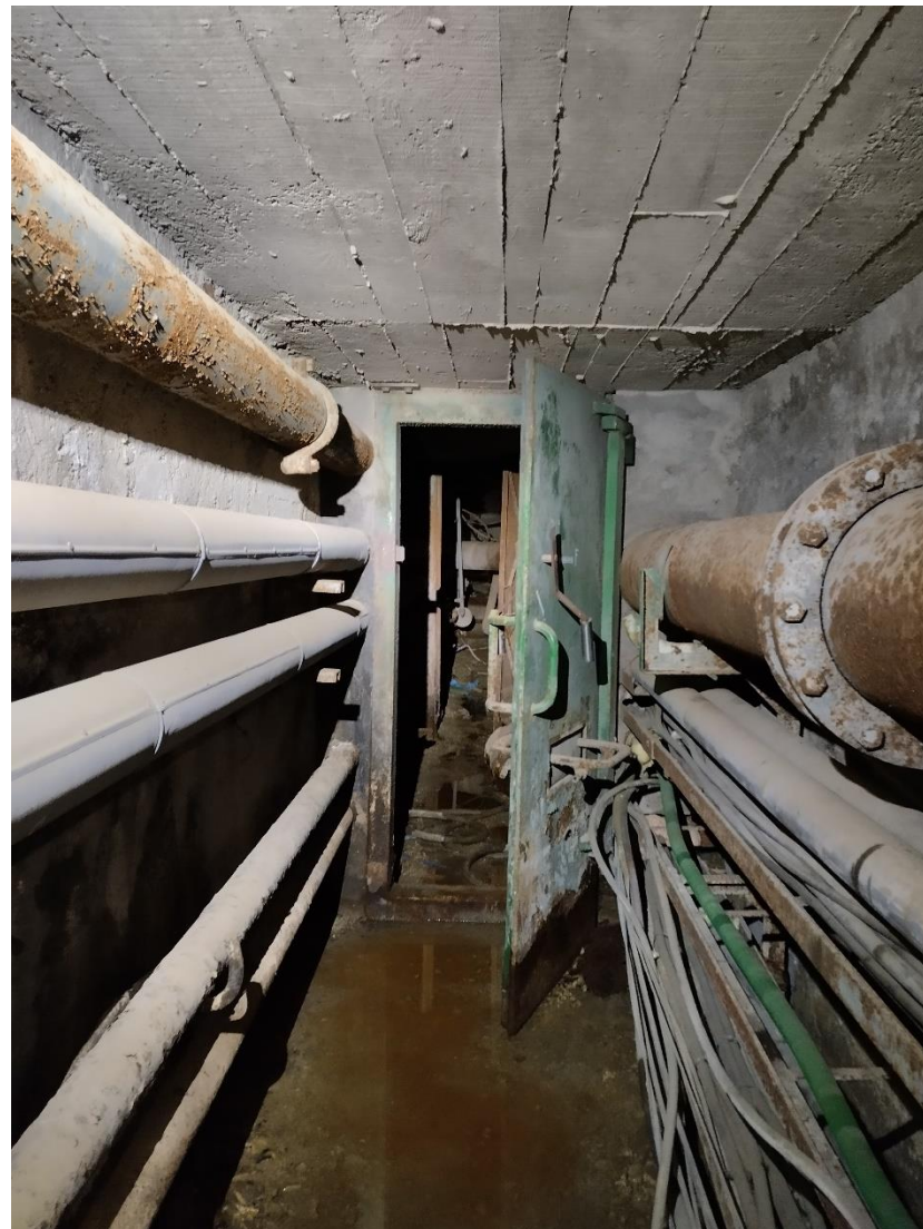
Photo 2 : Galerie n°1 - Entrée
