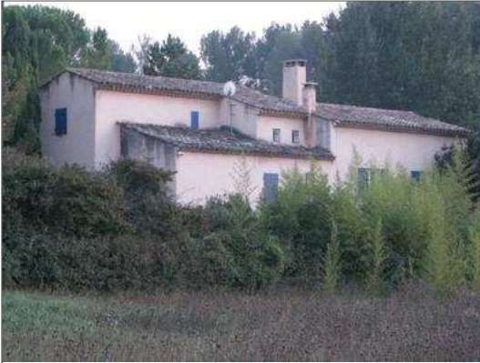
Photo. 4: Exemple de bâtiment de la typologie « Maison Individuelle – Maçonnerie de pierre »
