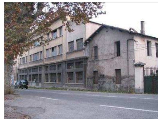
Photo. 9: Exemple de bâtiment de la « Usine en ossature béton armé » (second plan)
