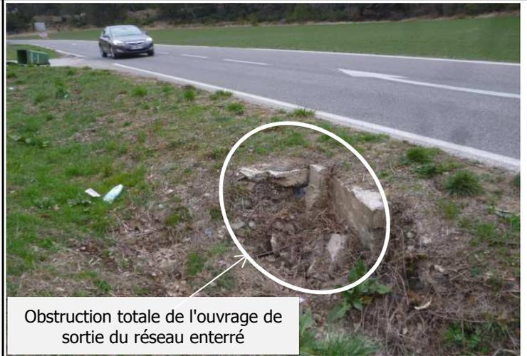
Obstruction totale de l'ouvrage de sortie du réseau enterré
