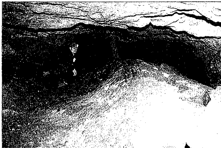
Photo n°3 - Soufflage du mur : Guide technique "cavités souterraines"
