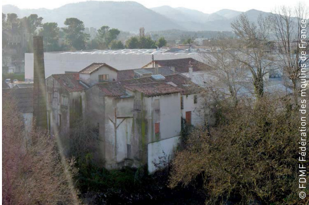
➤ Moulin de la Peyronne avant démolition partielle
