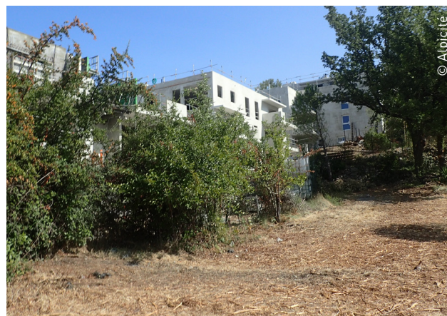
➤ Nouvelles constructions au nord-ouest du périmètre
