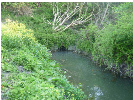
Inondation au niveau du tunnel sous le terril Barlin-Hersin (Nord) © Jacky Mikolajczak
