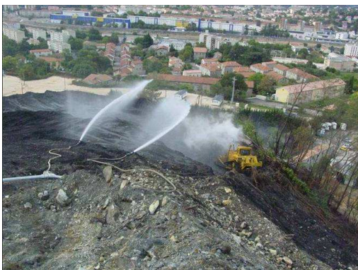
Terril en combustion, charbon, mine de Rochebelle, 30 - © GEODERIS
