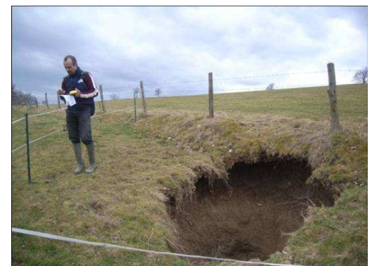
Effondrement localisé, mine de charbon, concession de Bert, 03 - © GEODERIS
