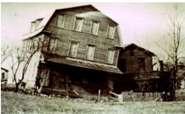
Domage sur une habitation en raison de la survenance d'un affaissement – (source : © GEODERIS)
