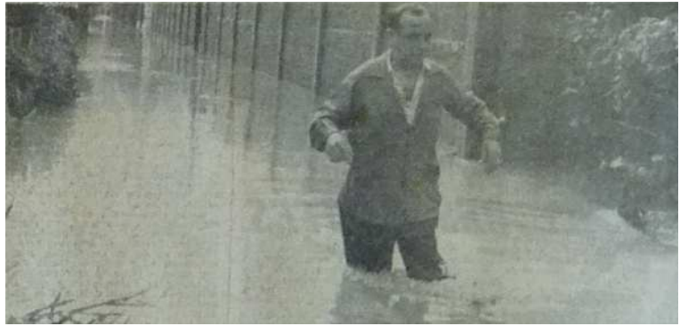
Figure 7 : Rue inondée à la Penne-sur-Huveaune suite à la crue de l'Huveaune du 11 novembre 1935
